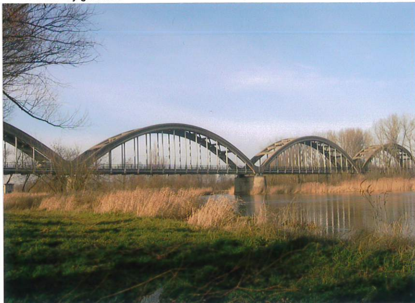
Fot. 1. Widok na most białobrzegi od strony południowo-wschodniej, 2018.
