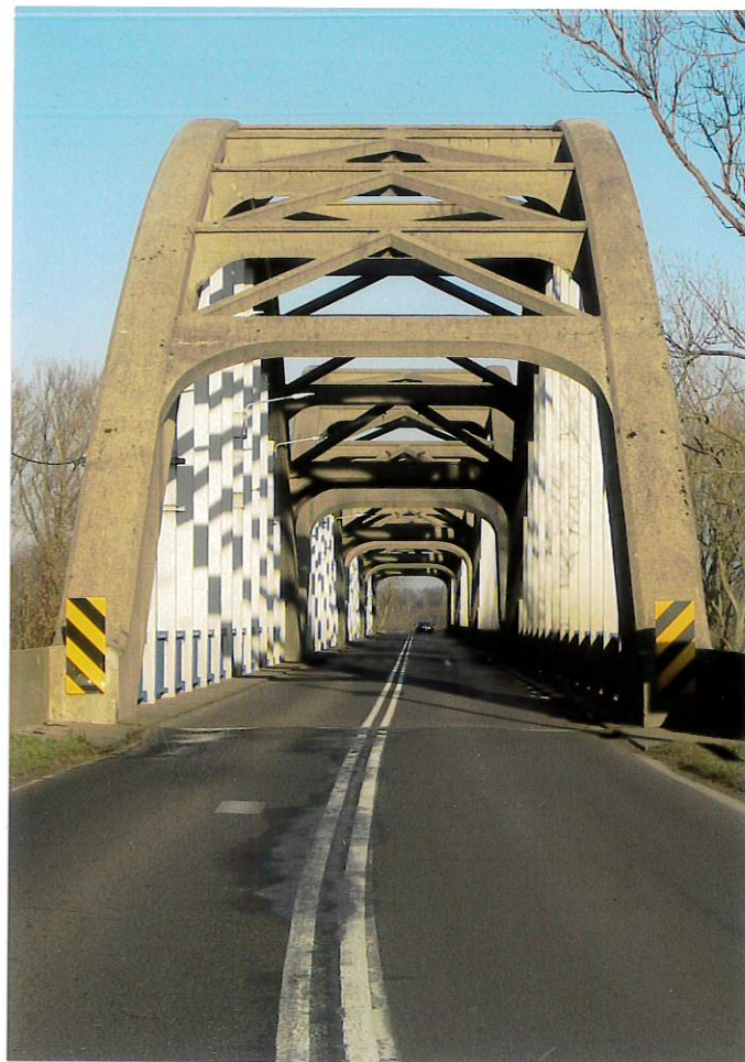
Fot. 3. Widok na most białobrzegi od strony południowo-zachodniej, 2018.
